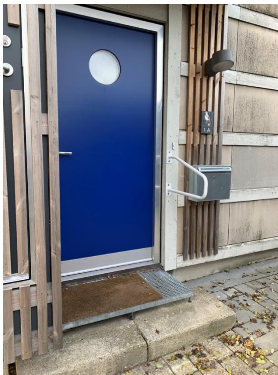
Figur 34. Indgangsdør i Albertslund
